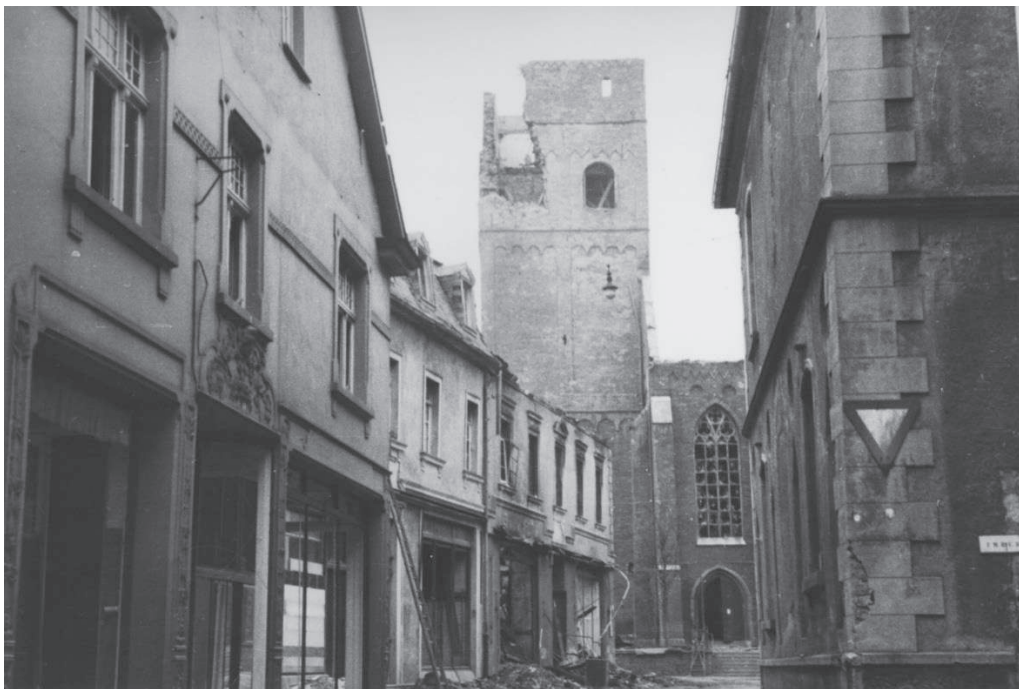
Die ausgebrannte Pfarrkirche von der Wasserstraße aus. (Foto: Theodor Frey / Frey Media).
